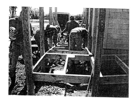
ATTACHED END JOIST AT THE ANGLE OF THE CUT
